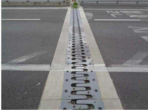
신축이음 A2 상태양호
