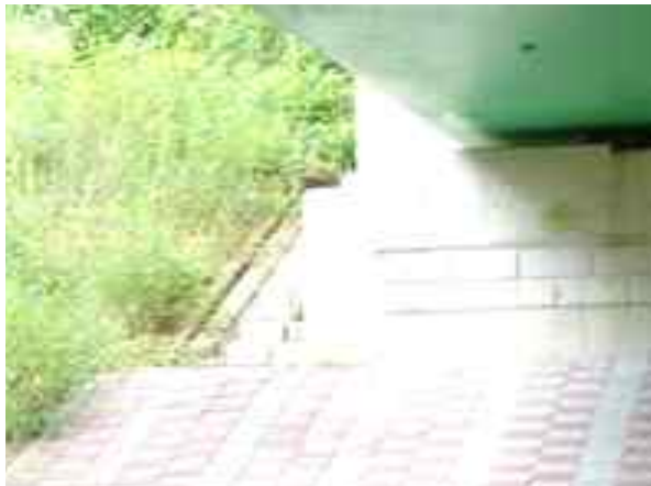
점검시설 상태양호(현재 식생)
