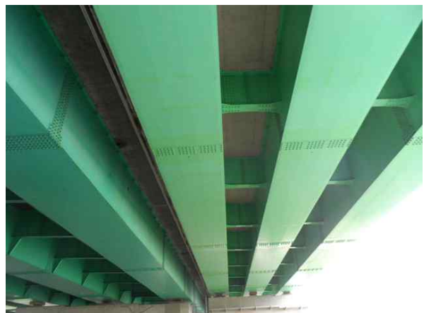
가로보 S2 상태양호
