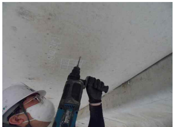
탄산화깊이 측정 현황
