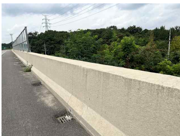
방호벽 S1 상태양호
