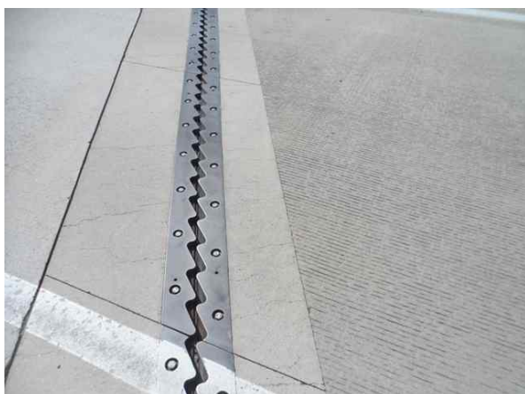
A1 후타재 균열(Cw=0.3mm미만)
