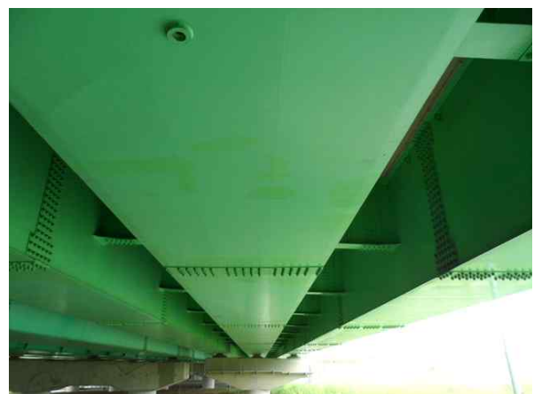
거더외부 S2 상태양호
