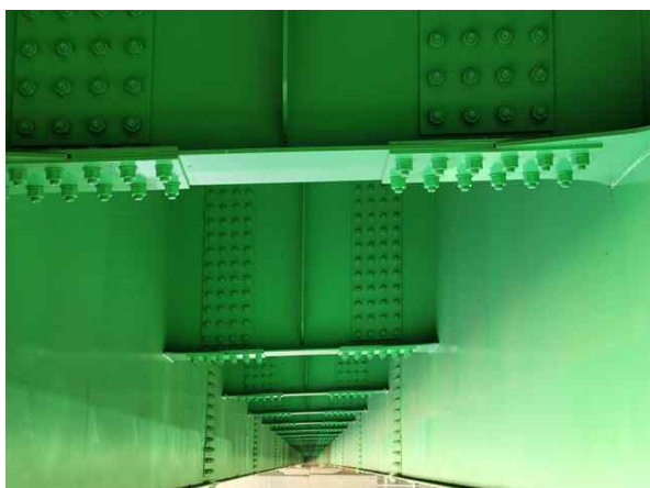
가로보 S3 상태양호
