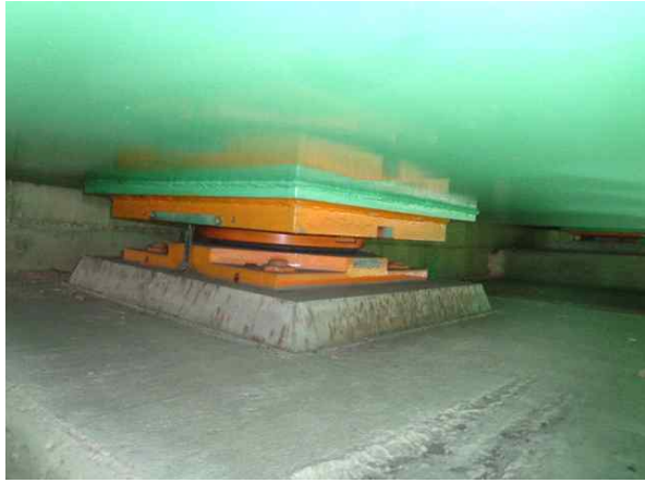
교량받침 A1-Sh2 상태양호
