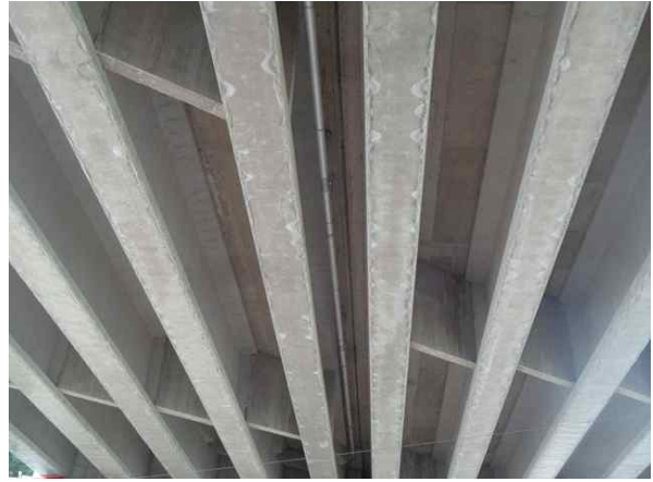
배수관 상태 양호-서울방향
