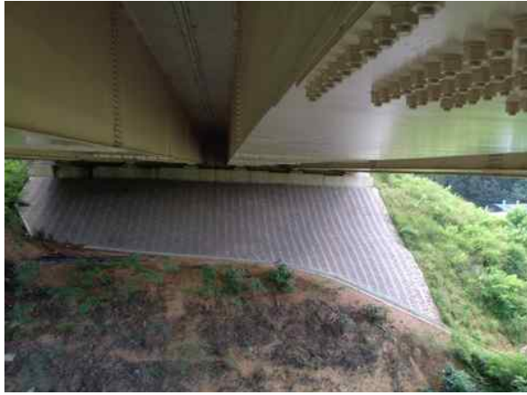
교대 상태양호 - 금회
