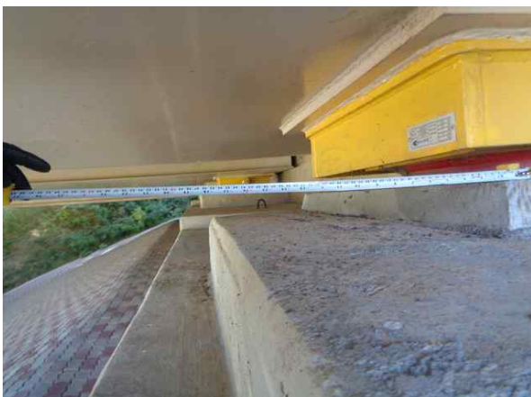
반침장치 연단거리 측정
