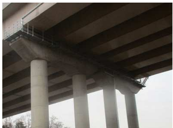
점검로 상태양호 - 금회
