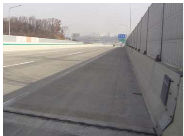
방호벽 상태양호 - 22년 상반기
