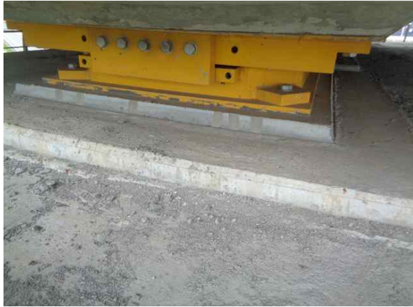
P1-Sh1 받침몰탈균열 보수
