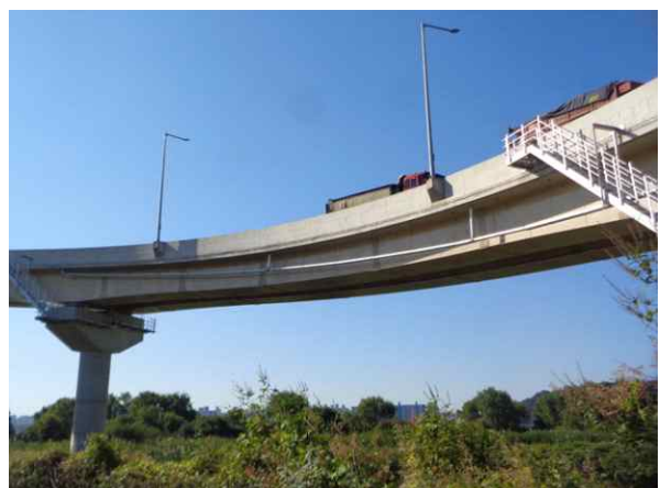
배수관 상태 양호
