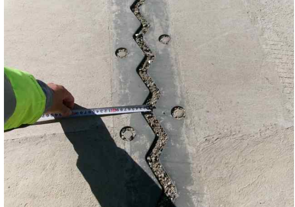
신축이음 이동량 측정
