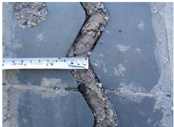
신축이음 이동량 측정
