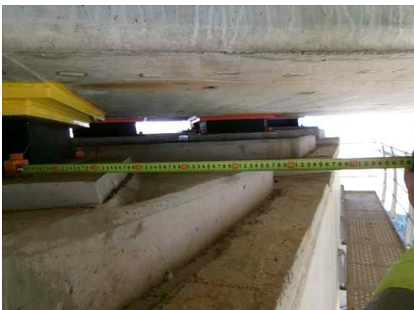
받침장치 연단거리 측정
