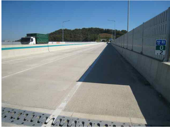
교면포장 상태양호 - 금회
