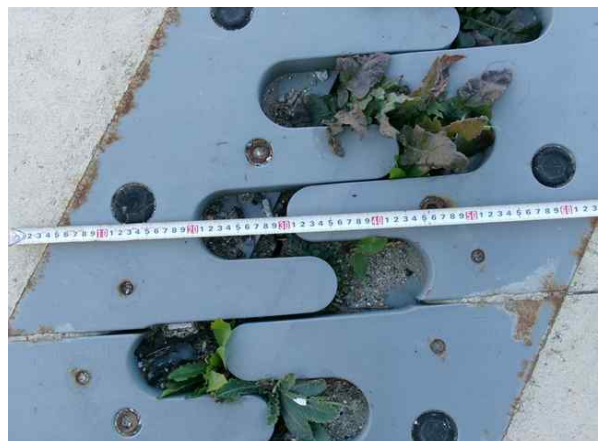
신축이음 이동량 측정
