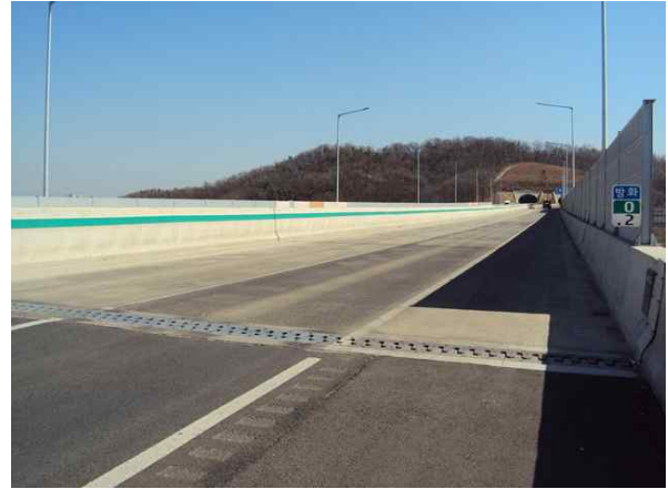
교면포장 상태양호 - 22년 상반기
