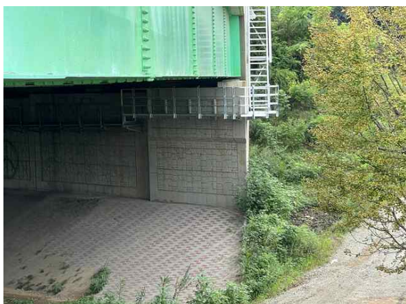
교대 A2 상태양호
