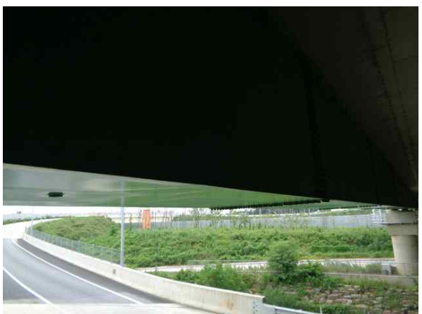
거더외부 S3 상태양호
