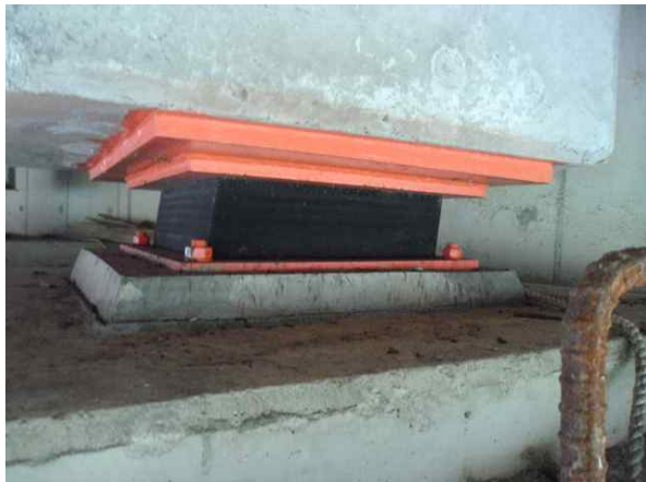
교량받침 A2-SH5 상태양호-서울방향
