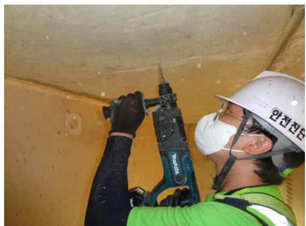
탄산화깊이 측정 현황
