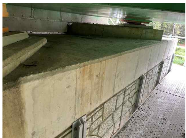
교대 A2 상태양호
