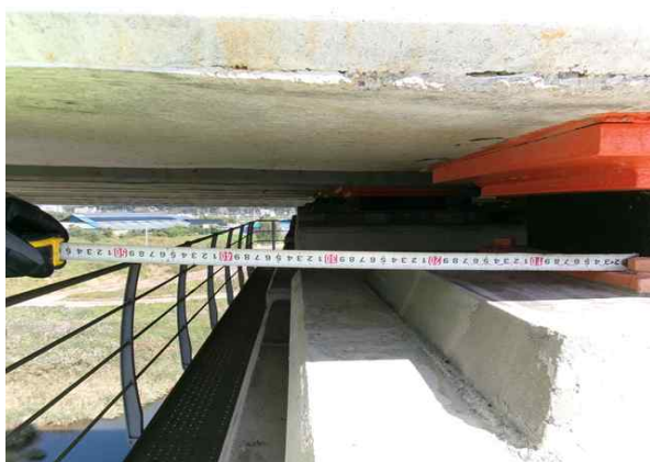
받침장치 연단거리 측정
