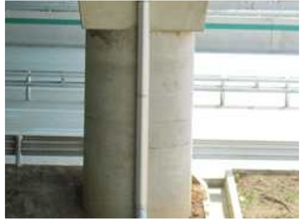
교각 P1 기둥부 상태양호
