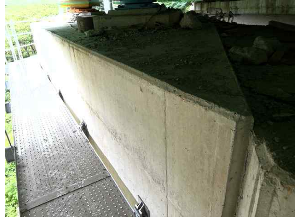
교각 P1 코핑부 상태양호
