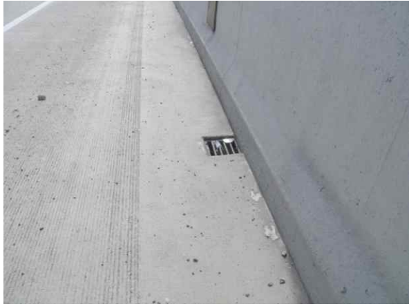
배수구 상태 양호
