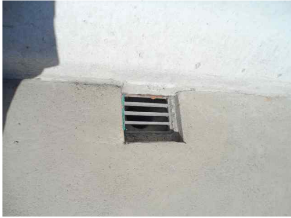
배수시설 배수구 상태양호
