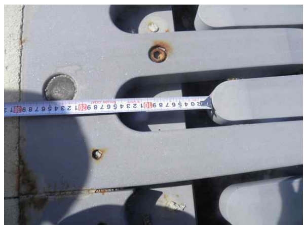
신축이음 이동량 측정
