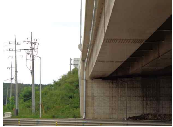
배수관 상태 양호
