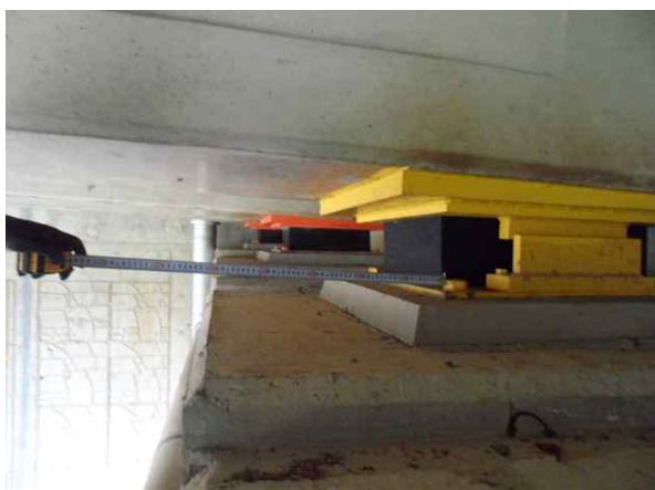
받침장치 연단거리 측정
