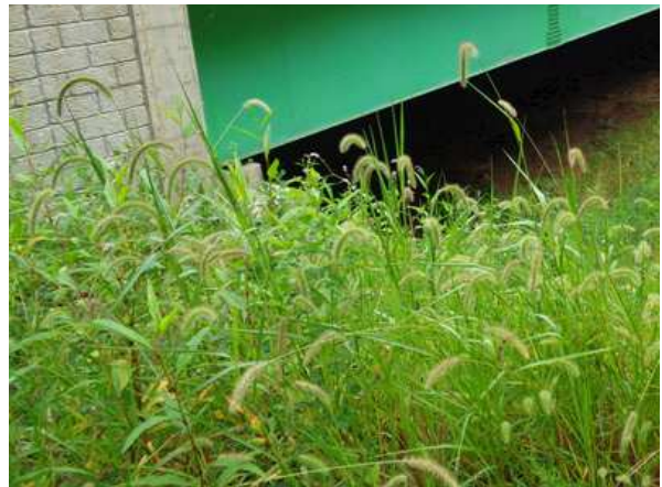
점검시설 상태양호(현재 식생)
