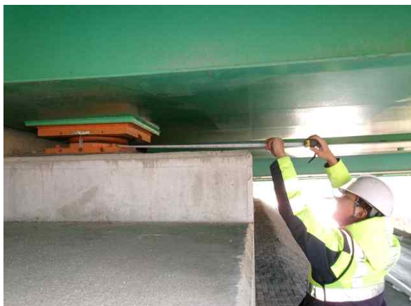
받침장치 연단거리 측정
