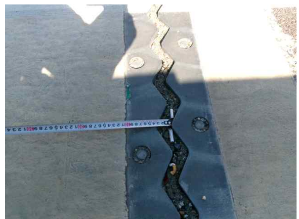
신축이음 이동량 측정
