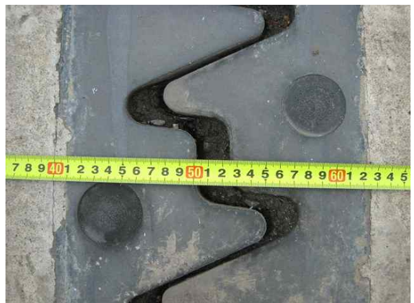
신축이음 이동량 측정
