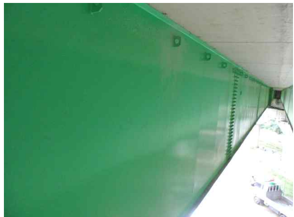
거더외부 S2 상태양호
