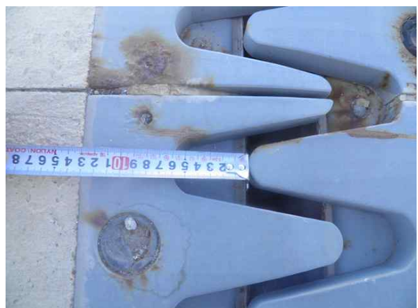
신축이음 이동량 측정
