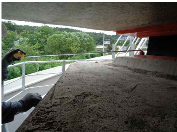
반침장치 연단거리 측정
