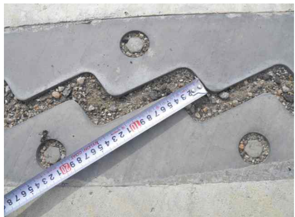
신축이음 이동량 측정
