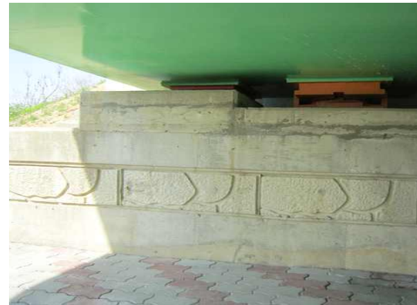
교대 A1 상태양호
