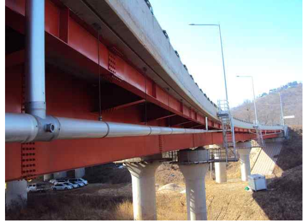
배수관 상태 양호
