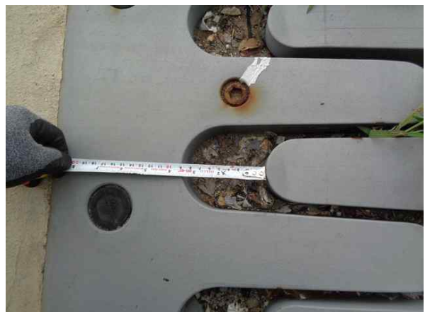
신축이음 이동량 측정
