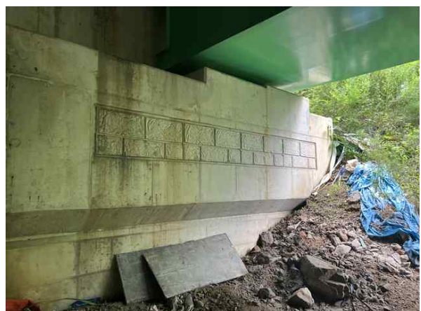
교대 A2 상태양호
