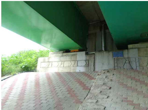
교대 A1 상태양호
