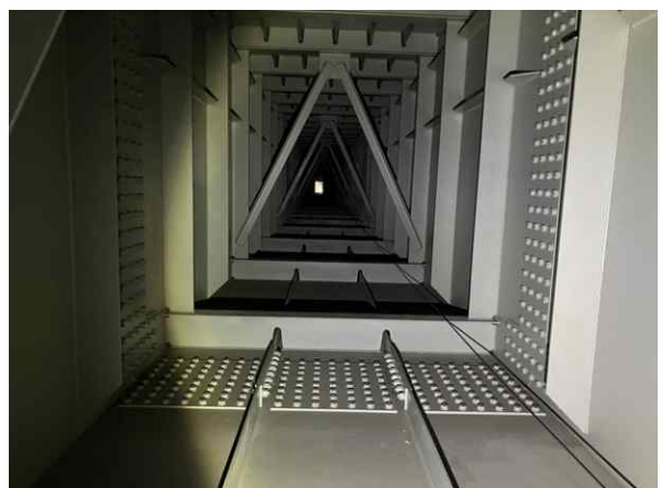
거더내부 상태 양호
