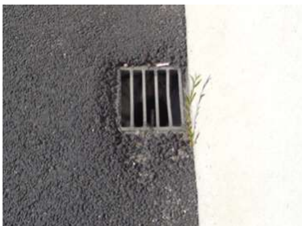
배수구 상태 양호
