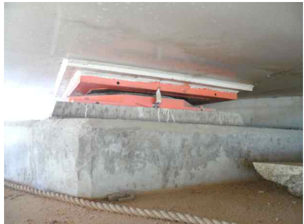
A1-Sh3 상태 양호
