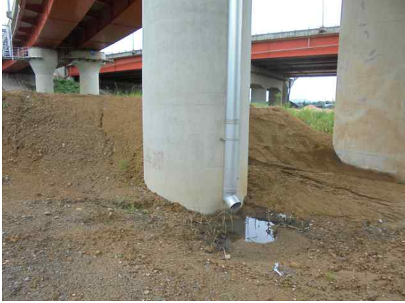
배수관 상태 양호
