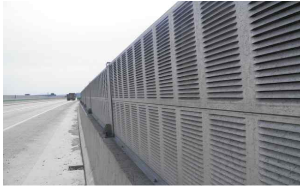
방호벽, 방음벽 전경
