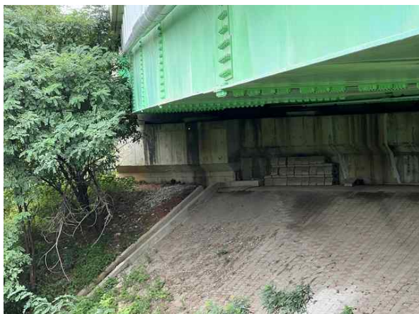
교대 A1 상태양호
