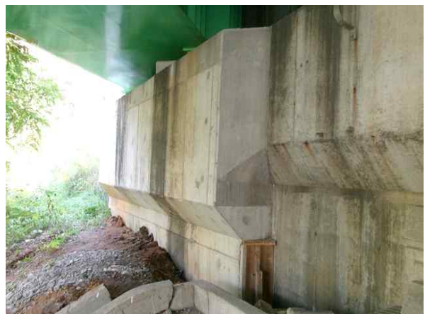
교대 A1 상태양호
