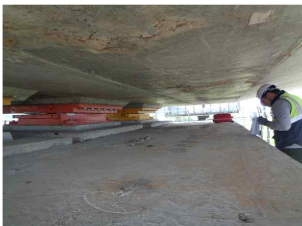
받침장치 연단거리 측정
