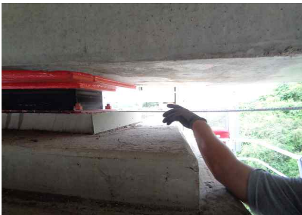
받침장치 연단거리 측정
