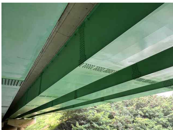
거더외부 S1 상태양호
