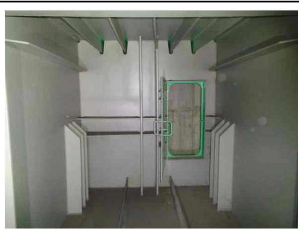
거더내부 S2 상태양호
