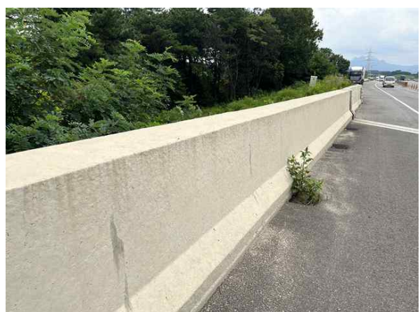
방호벽 S1 상태양호
