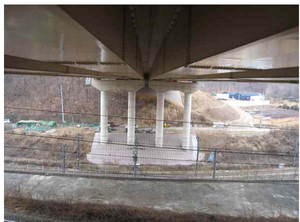
교각 상태양호 - 22년 상반기
