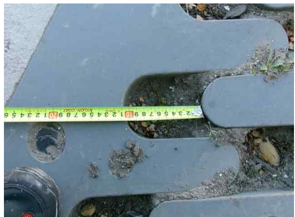
신축이음 이동량 측정
