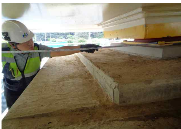
받침장치 연단거리 측정
