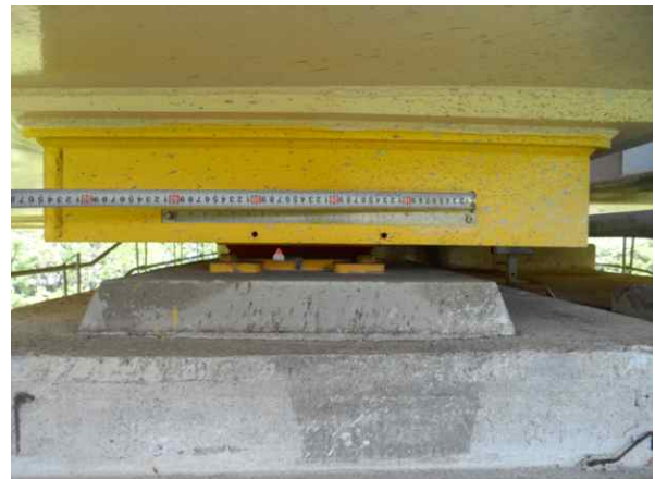
교량 받침 가동량 측정
