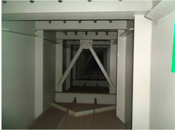
거더내부 S1 상태양호
