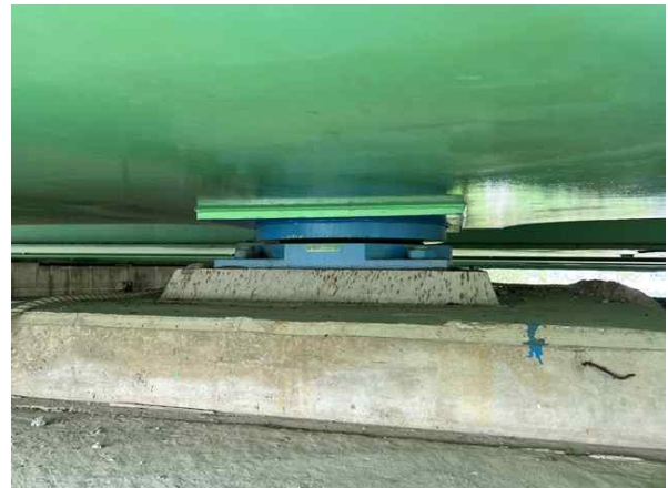
교량받침 P1-Sh1 상태양호
