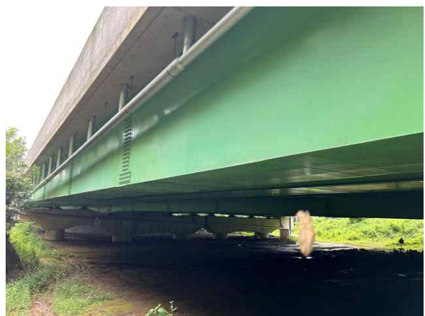
거더외부 S2 상태양호
