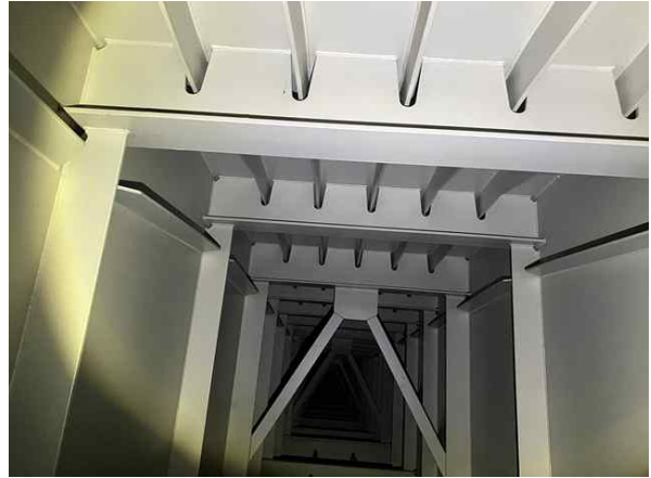
거더내부 S2 상태양호
