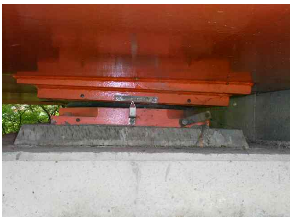
받침장치 가동량 측정
