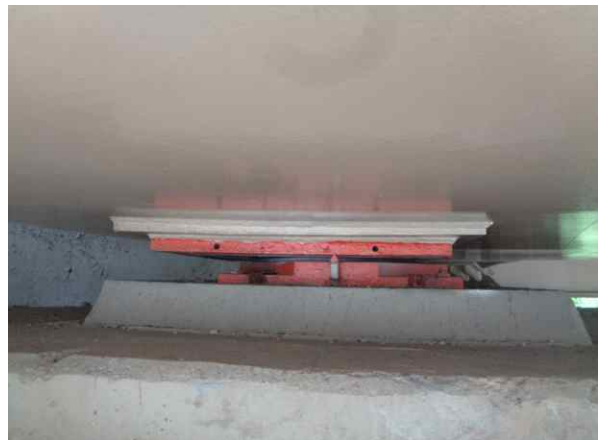
교량 받침 가동량 측정
