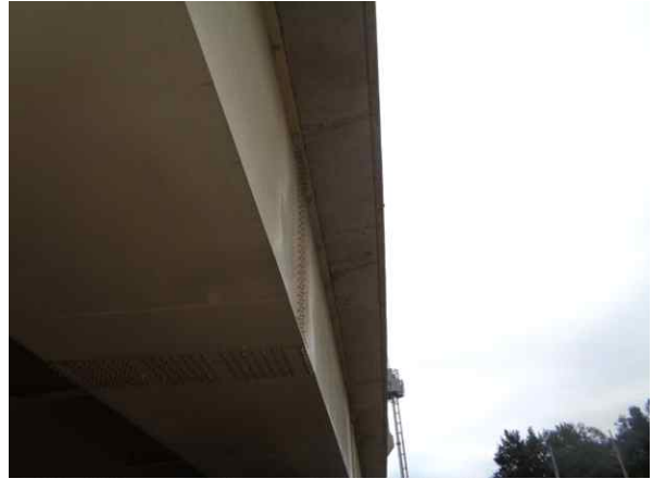
바닥판 하면 S1 캔틸레버부 상태 양호
