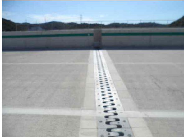
신축이음 P3 상태양호
