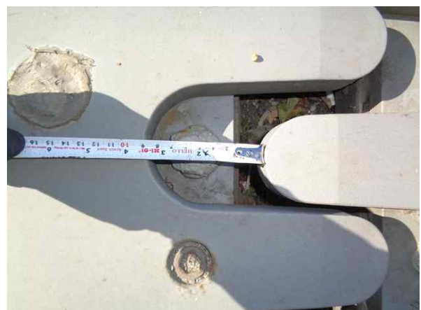
신축이음 이동량 측정
