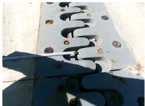
신축이음 이동량 측정
