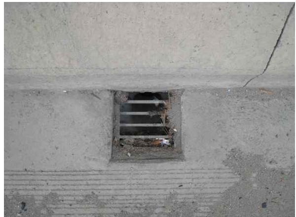
배수구 상태 양호
