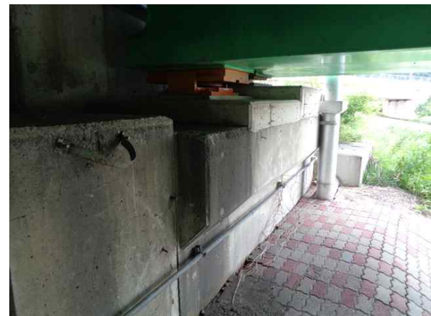
교대 A2 상태양호
