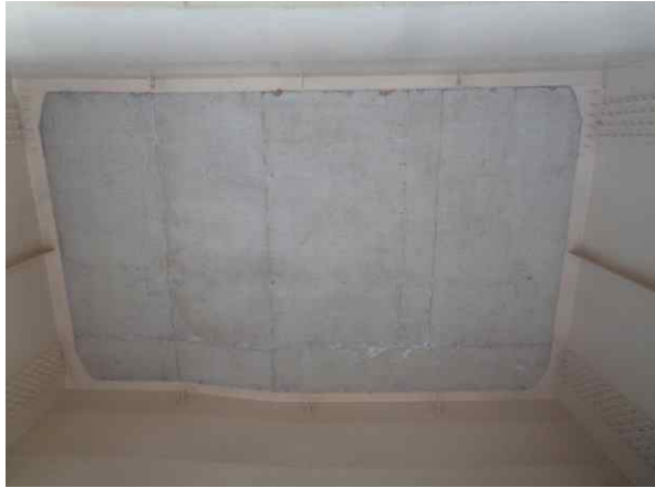
바닥판 하면 S1 상태 양호
