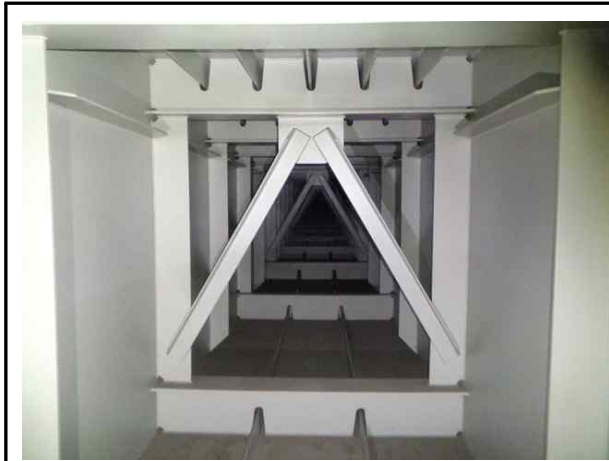
거더내부 S1 상태양호
