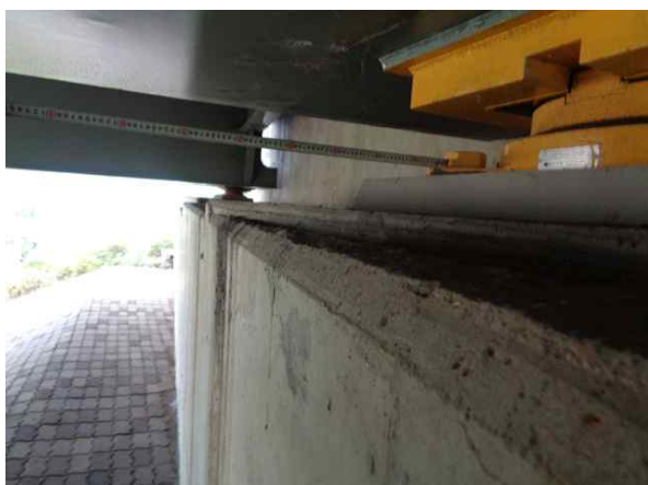
받침장치 연단거리 측정
