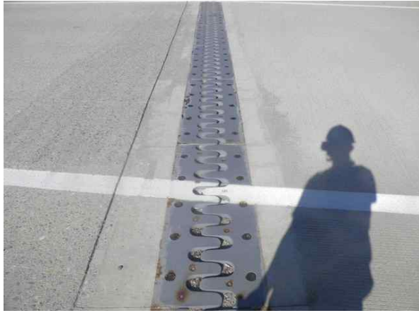
신축이음 A1 상태양호
