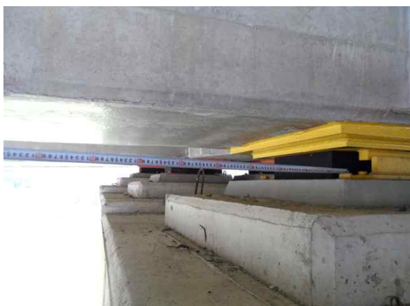
받침장치 연단거리 측정
