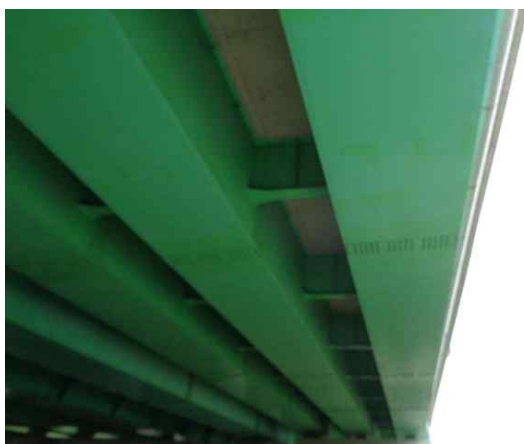
거더외부 S1 상태양호
