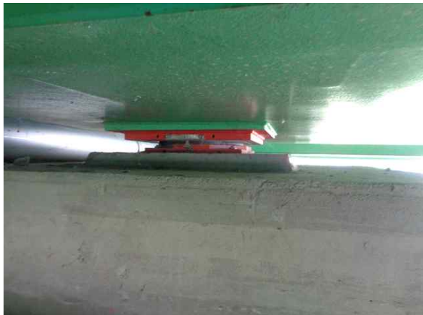
교량반침 A2-Sh1 상태양호
