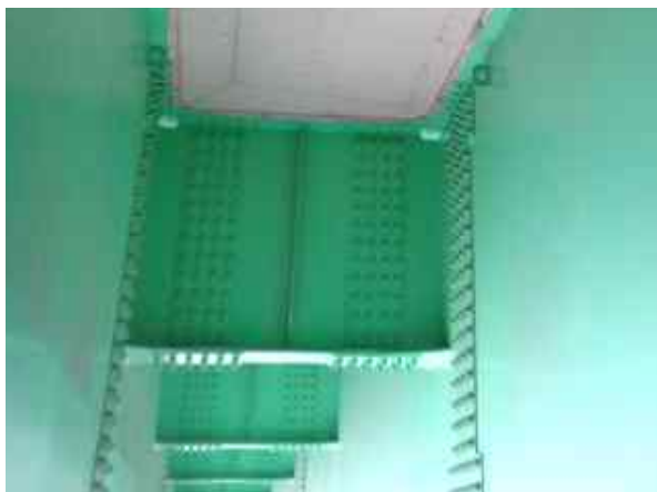
가로보 S1 상태양호
