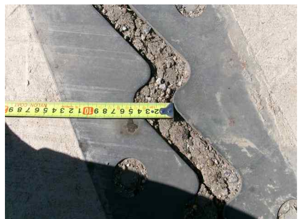
신축이음 이동량 측정
