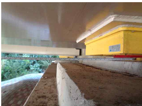
받침장치 연단거리 측정
