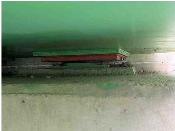
교량받침 A2-Sh2 상태양호
