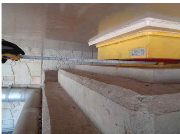
받침장치 연단거리 측정
