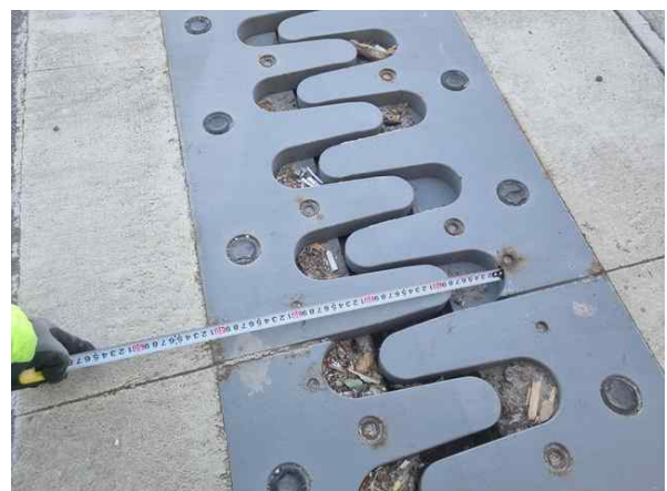
신축이음 이동량 측정
