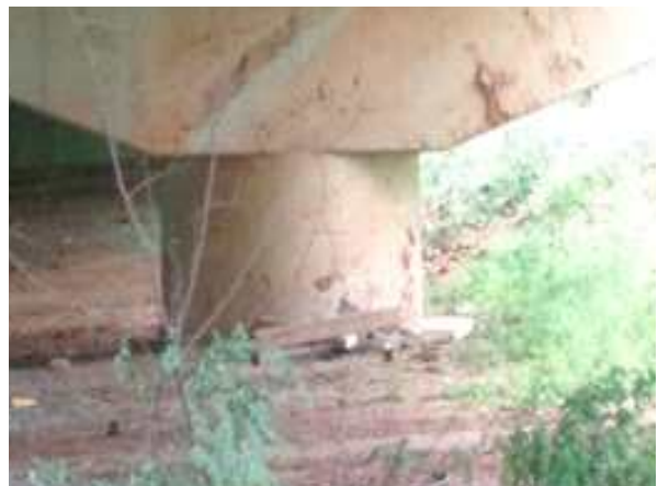
교각 P1 기둥부 상태양호
