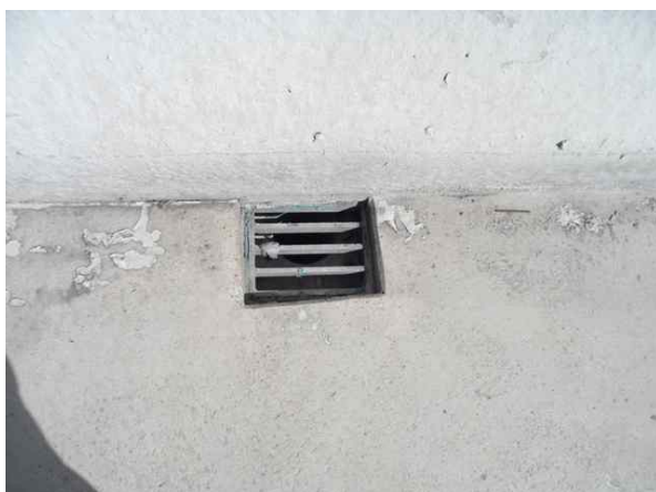
배수구 상태 양호-문산방향
