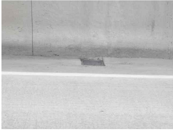
배수구 상태 양호-서울방향
