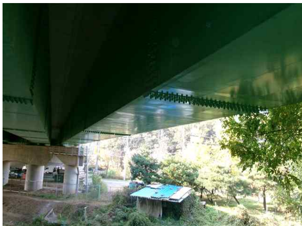
거더외부 S1 상태양호
