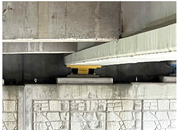
교량받침 A1-SH4 상태양호-서울방향
