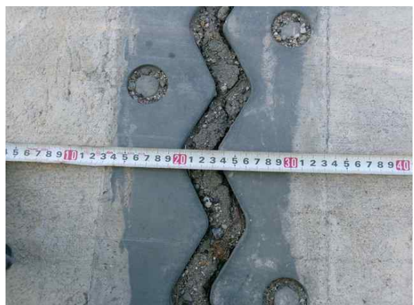
신축이음 이동량 측정
