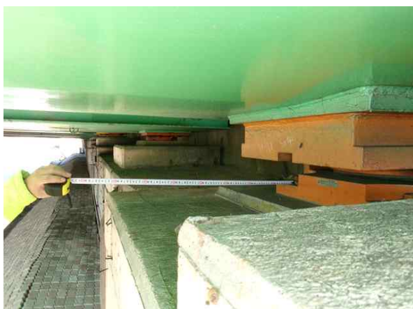
받침장치 연단거리 측정
