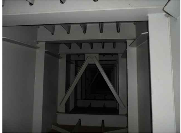
거더내부 S4 상태양호
