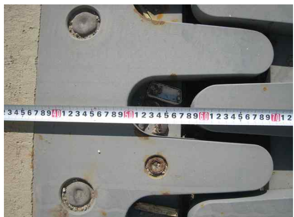
신축이음 이동량 측정
