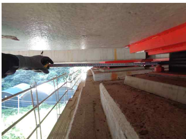
받침장치 연단거리 측정
