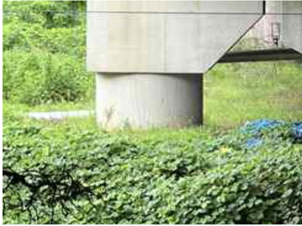
교각 P1 기둥부 상태양호
