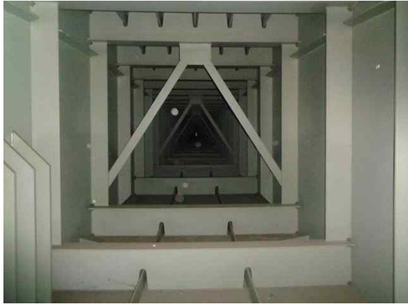
거더내부 S1 상태양호
