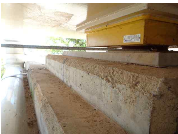
받침장치 연단거리 측정
