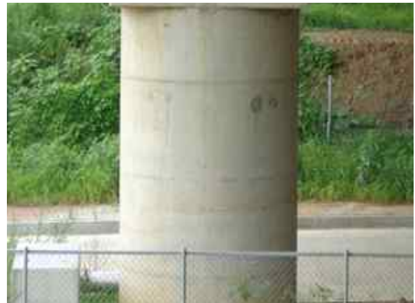
교각 P3 기둥부 상태양호
