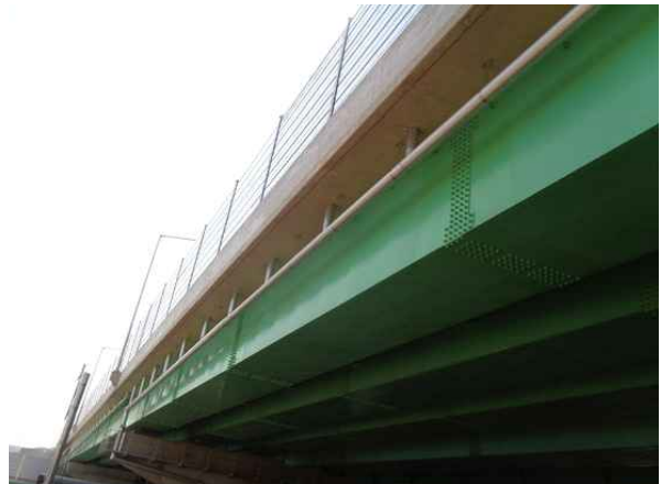
배수시설 S4 배수관 상태양호
