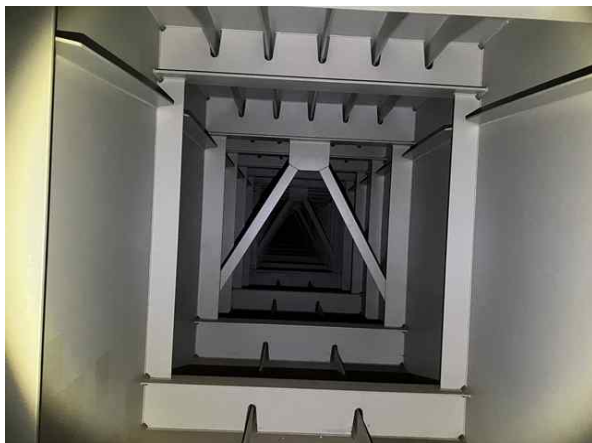
거더외부 S1 상태양호
