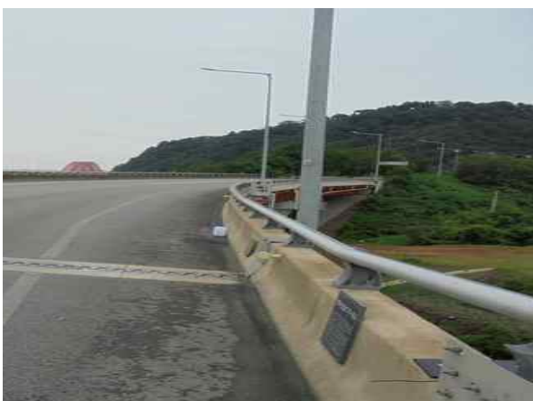
난간 및 연석 상태양호
