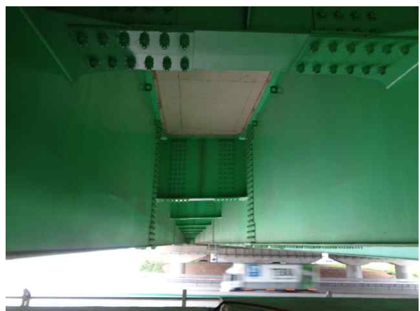
가로보 S4 상태양호
