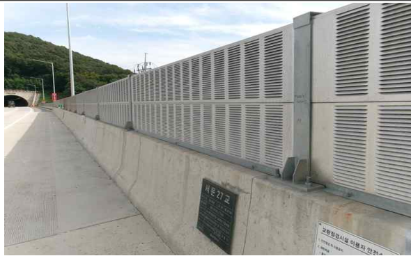
방호벽, 방음벽 전경
