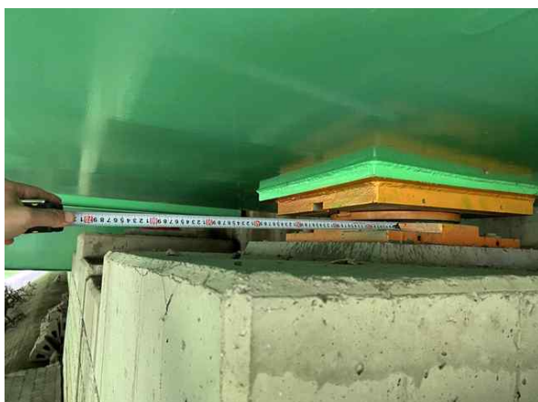
받침장치 연단거리 측정
