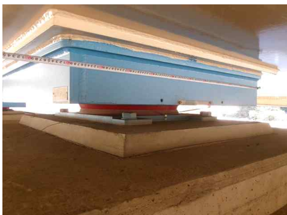
받침장치 연단거리 측정
