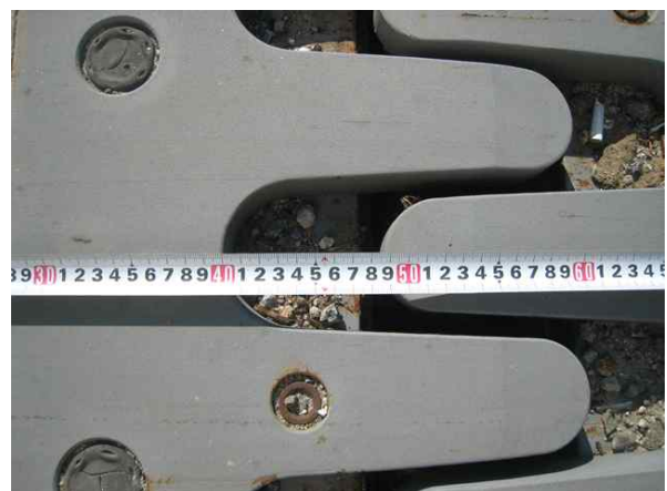
신축이음 이동량 측정
