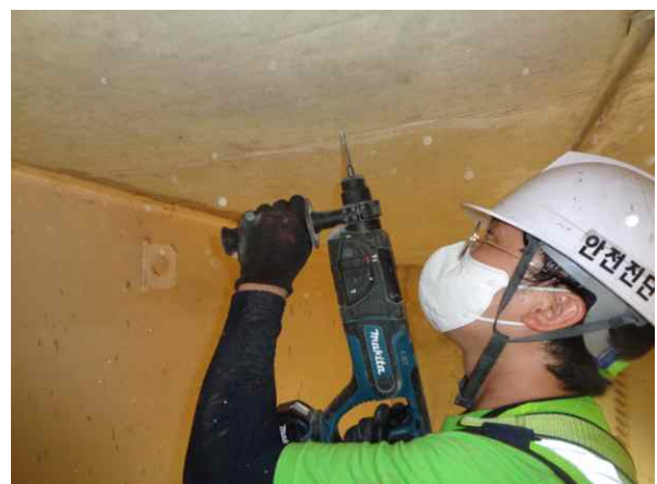
탄산화깊이 측정 현황
