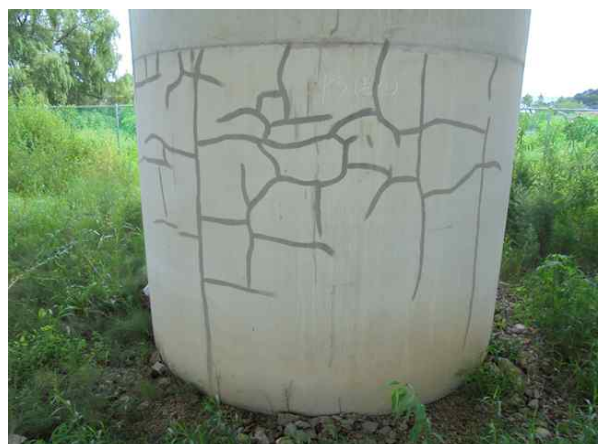
P3 기존보수부 상태양호
