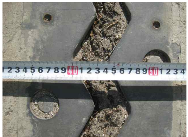
신축이음 이동량 측정
