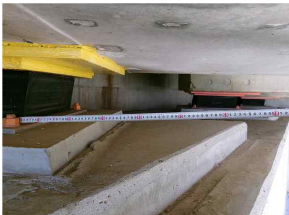
받침장치 연단거리 측정
