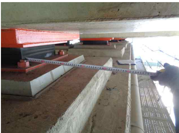
받침장치 연단거리 측정
