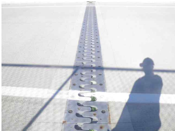
신축이음 P3 상태양호
