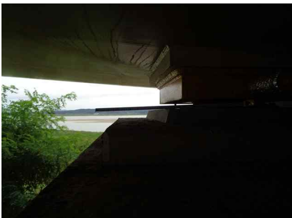
받침장치 연단거리 측정
