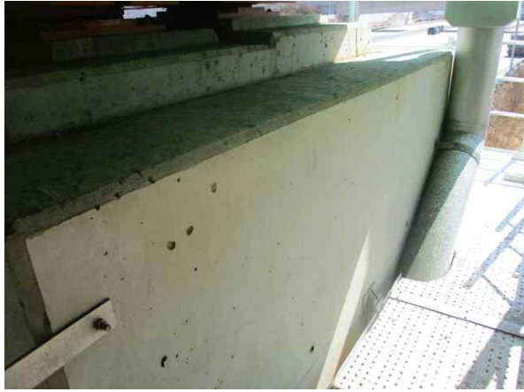
교각 P1 코핑부 상태양호
