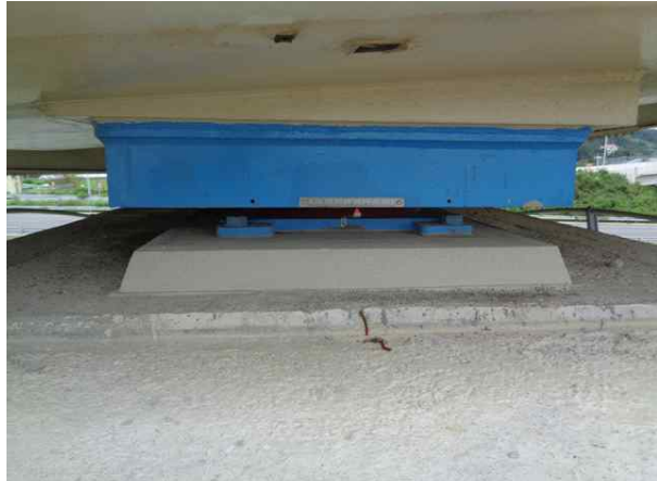
교량받침 P1-Sh2 상태양호
