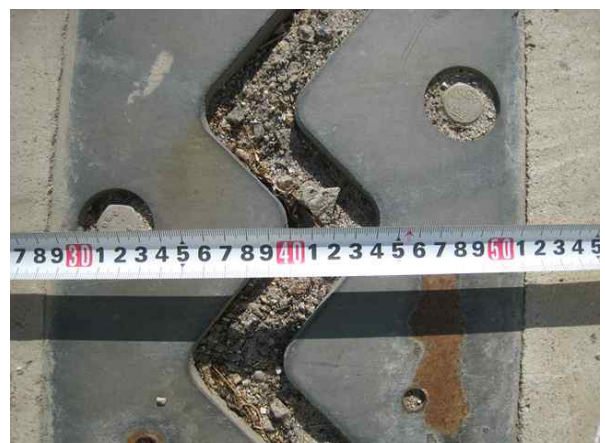
신축이음 이동량 측정
