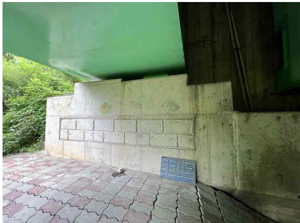
교대 A1 상태양호
