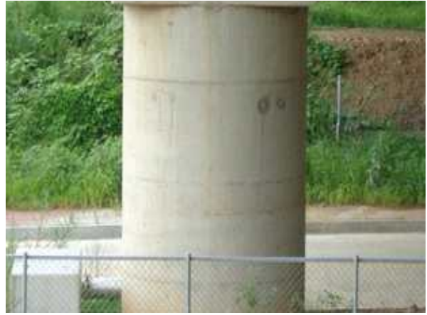
교각 P3 기둥부 상태양호
