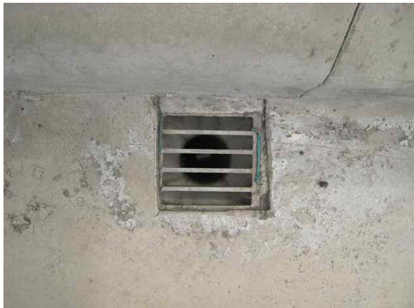
배수구 상태 양호
