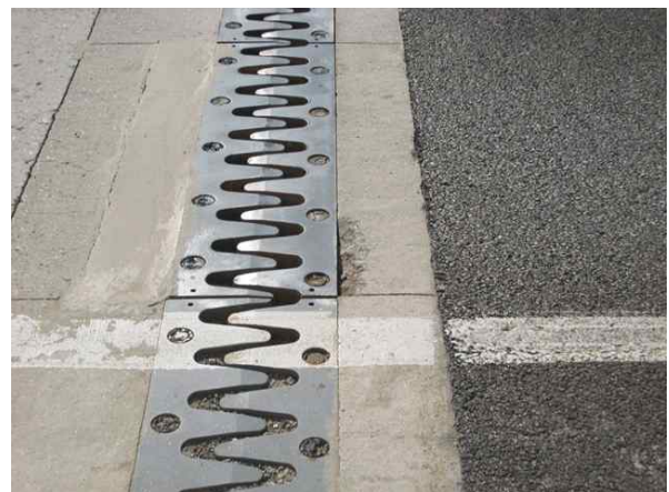
A1 후타재 파손 (0.2m×0.5m) - 금회
