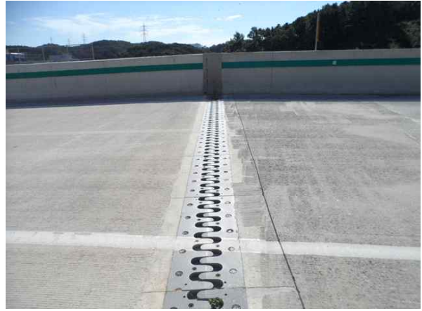
신축이음 A2 상태양호
