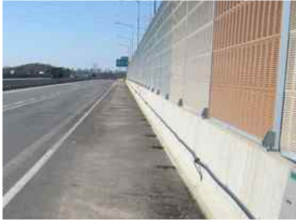
방호벽 S1 상태양호
