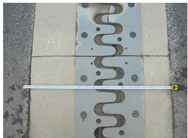
신축이음 이동량 측정
