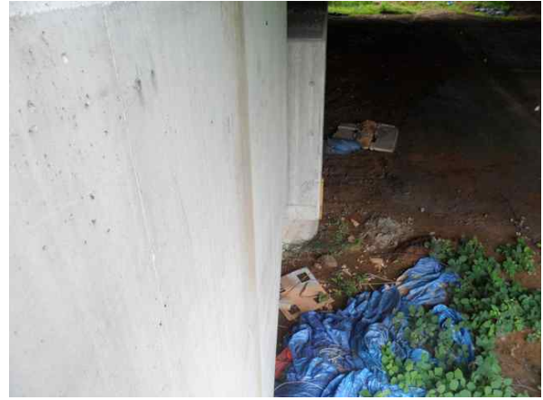
교각 P1 코핑부 상태양호
