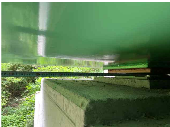
받침장치 연단거리 측정
