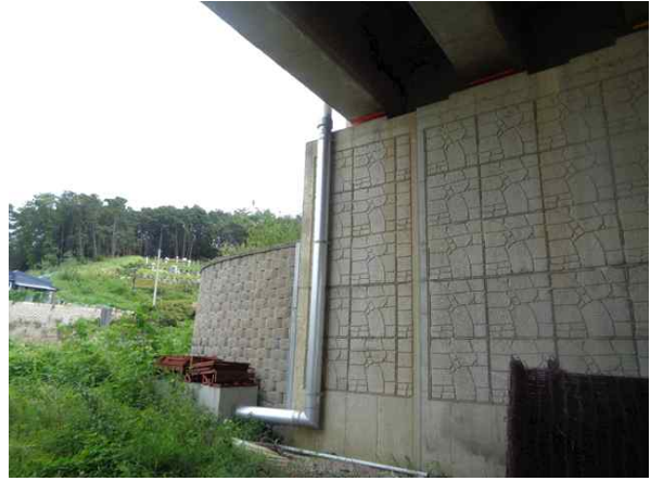
배수시설 배수관 상태양호
