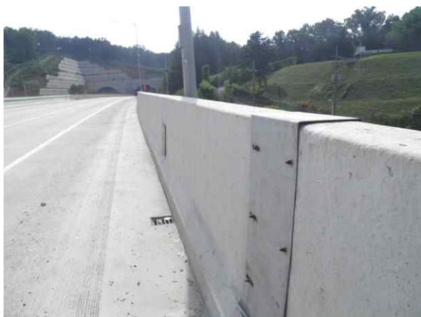
방호벽 상태 양호
