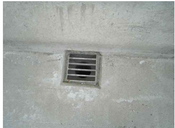
배수구 상태 양호
