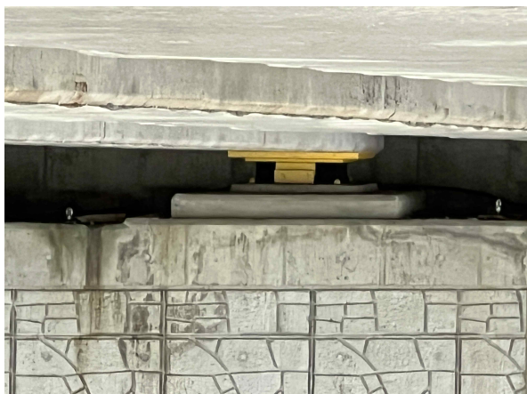
교량받침 A1-SH2 상태양호-문산방향
