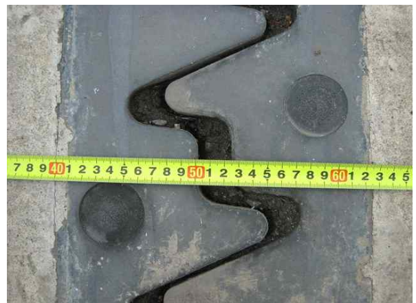
신축이음 이동량 측정
