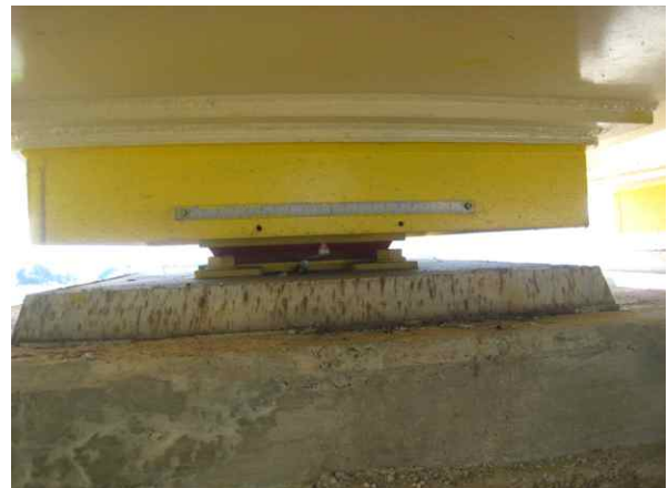
교량 받침 가동량 측정
