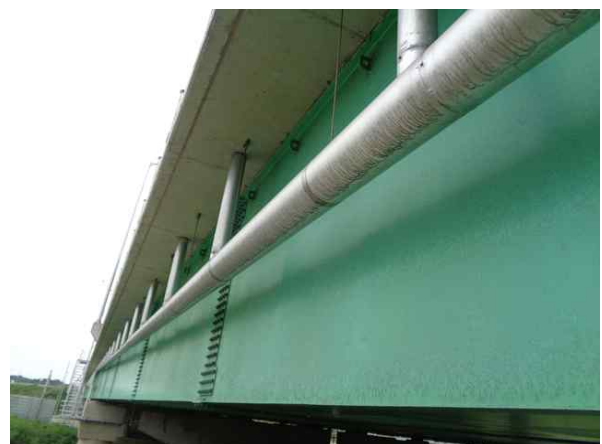
배수시설 S4 배수관 상태양호
