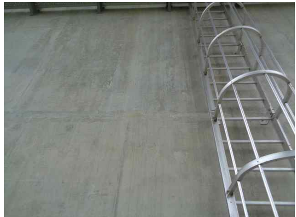
교각 P3 망상균열(1.2×2.5)
